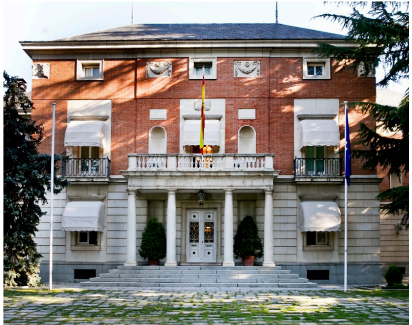
Fachada actual del Palacio de La Moncloa, 2018 Foto: Pool Moncloa
