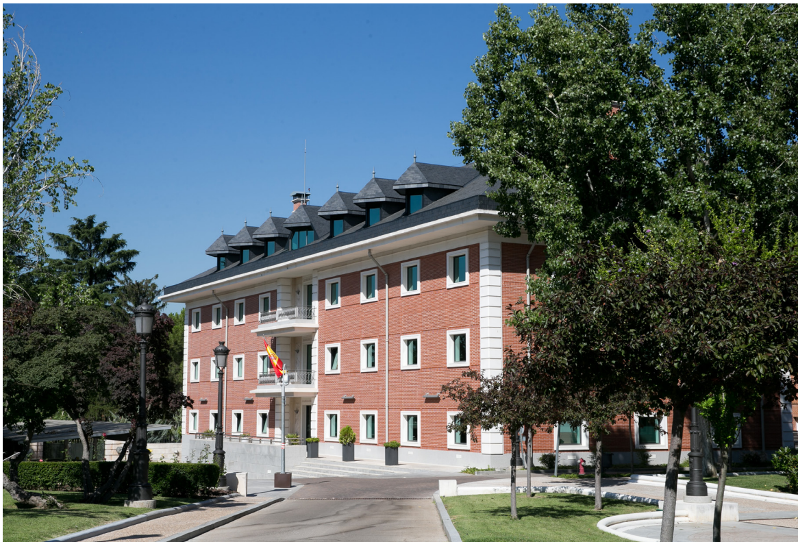
Fachada del Edificio del Ministerio de la Presidencia, Relaciones con las Cortes y Memoria Democrática, 2018.
